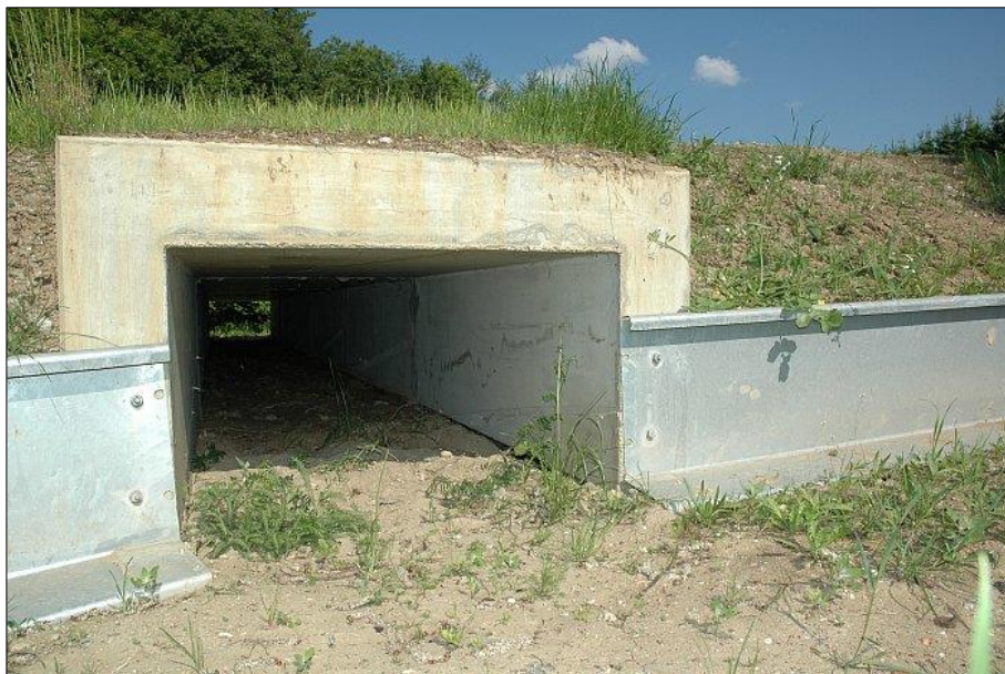
Figur 8-2: Principiel udformning af paddetunnel. www.amphibienschutz.at .
